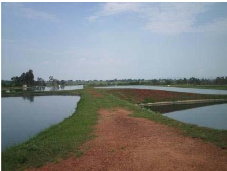
Figura 84 – ETE Barro Preto: Módulos 1 e 2
