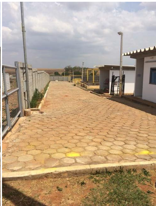
Figura 88 – Vista geral da ETE Escala
