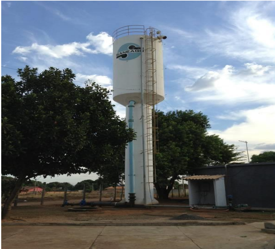
Figura 16 - Reservatório Elevado 100 m 3
