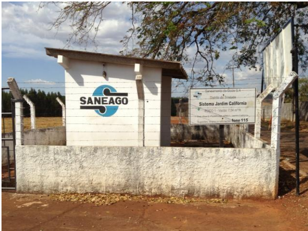
Figura 30 – Casa de Tratamento – CR Califórnia
