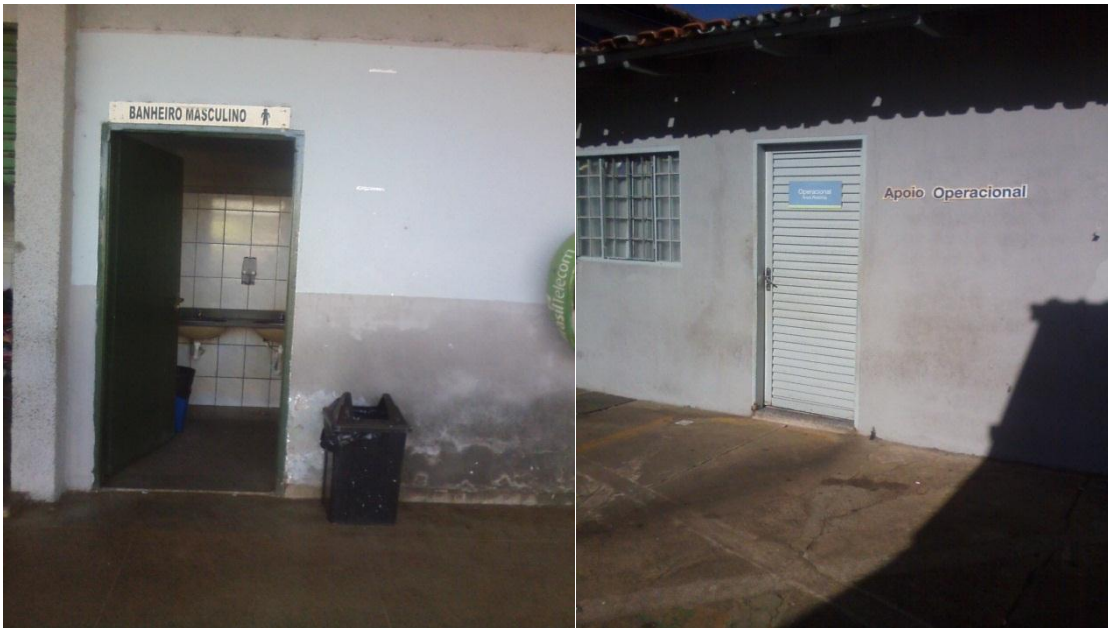
Figuras 108 e 109: Instalações (Banheiro e Apoio Operacional) do Terminal Rodoviário de Trindade
