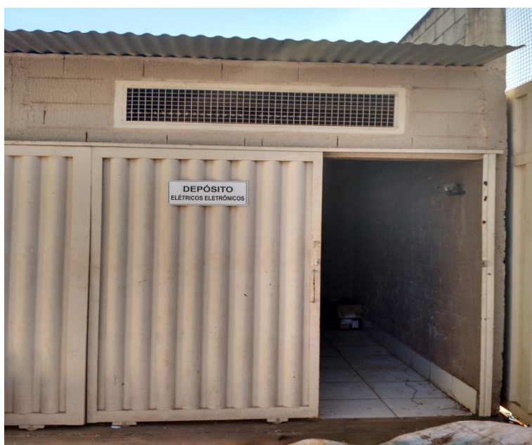
Figuras 97 a 99 - PROJETO RECICLAR da Vila Cottolengo Fonte: Vila Cottolengo (2016)
