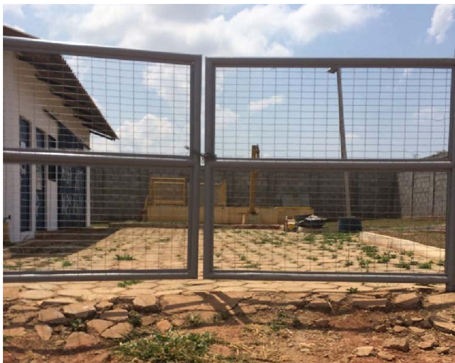
Figura 85 – Estação Elevatória EEE1
