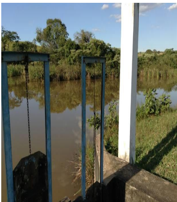
Figura 44 - Vista da captação a partir do canal
