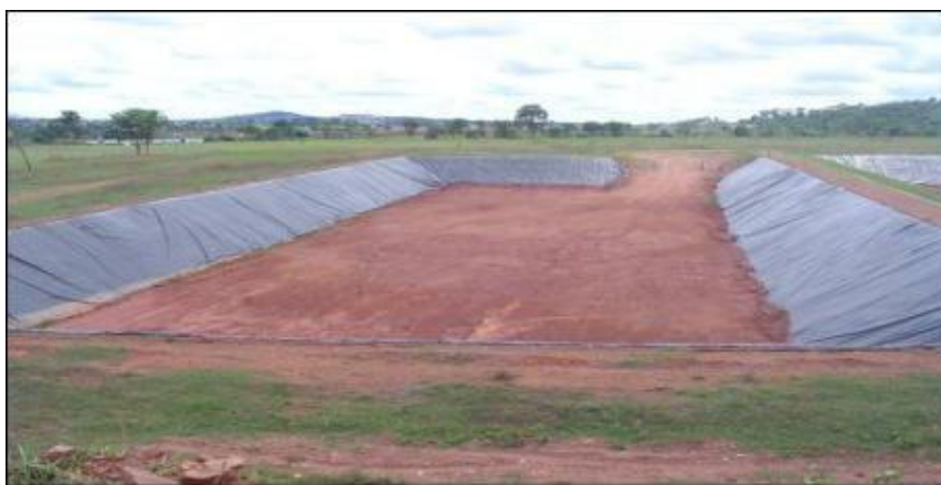
Figura 123: Trincheira construída no aterro de Trindade Fonte: Ferreira (2006)
