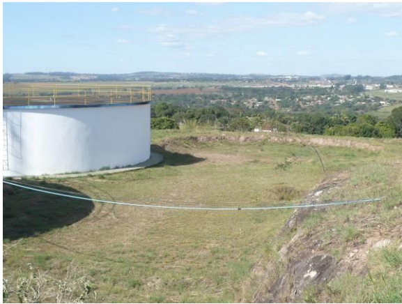
Figura 61 – Ao fundo escavação do novo RAP 1000 m 3
