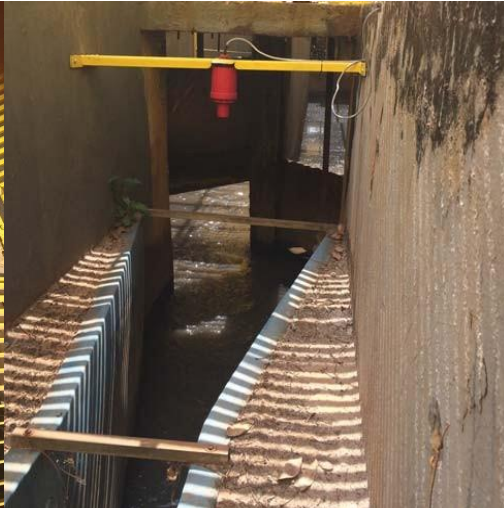
Figura 79 – Medidor Parshall, de 1'
